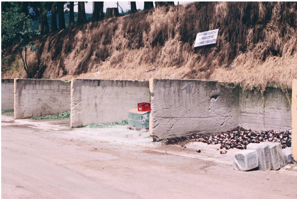
Foto 38 – Locales de almacenamiento para la producción defectuosa
