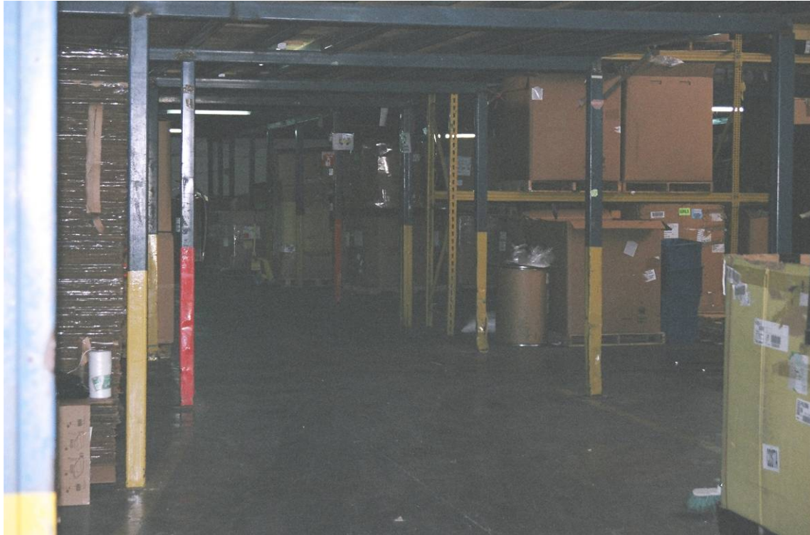
Foto 46 – Parte interna del galpón
