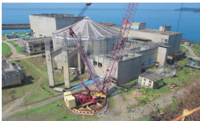
Figura 1 – Construção da usina de Angra 3
